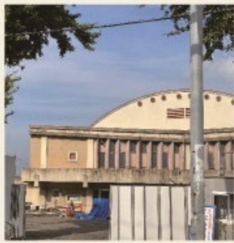
解体される大沢の第一体育館▶
