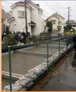
10/6 台風 18 号出羽掘り での土のう積み
